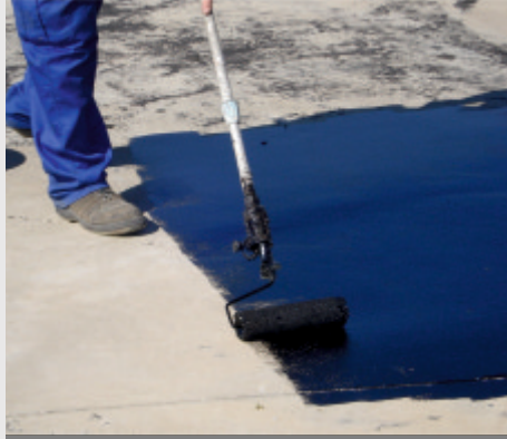
APPLICATION OF PRIMER
